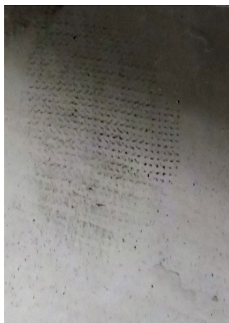
Ryc. 21. Ślad dederonu na drewnie
